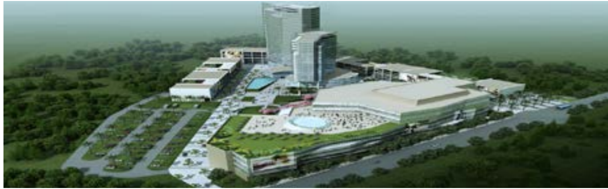
台灣金門，金門工商休閒園區第一期
