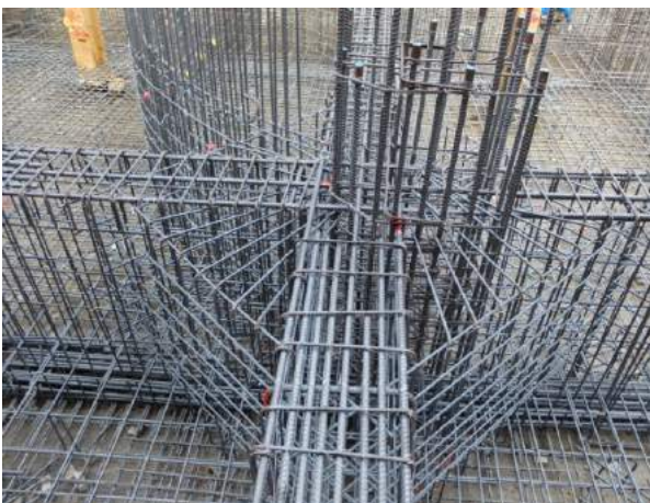
基礎擴柱綁紮
