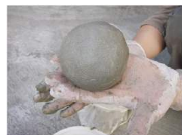
攪拌均勻後再塞入漏水處 (三分鐘內完成)
