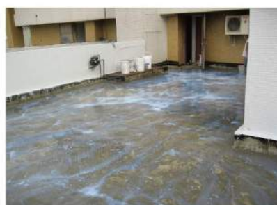
滲透底塗施作(防水整修地板)
