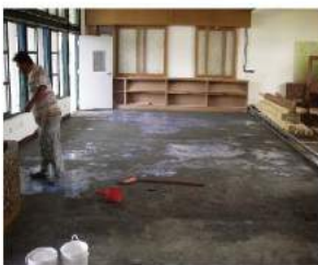
滲透底塗施作
