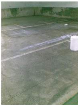
滲透底塗施作
