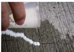
地坪裂縫修補
