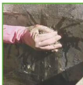
緊壓漏水處封阻堵漏
