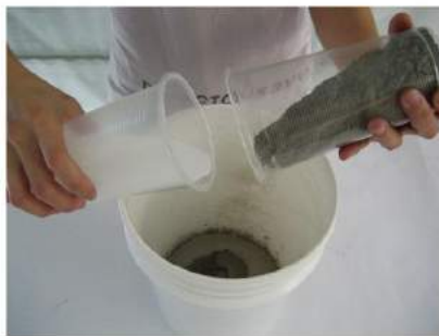
稀釋液樹脂與水泥砂漿1比5拌合 (建議砂漿配比为水泥1:砂1)
