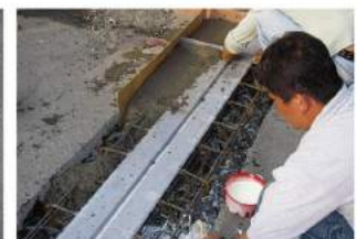
道路伸縮縫修補中
