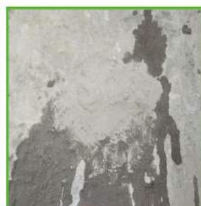
二十秒內瞬間凝固封阻湧水！
