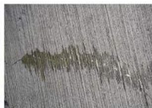
地坪裂縫修補完成面
