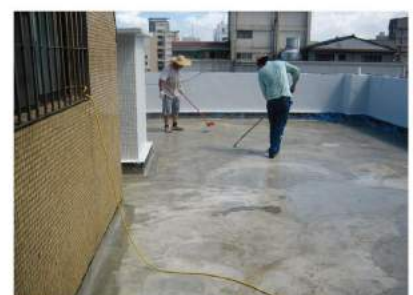
地坪整平樹脂砂漿施作完成
