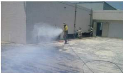
防水施工+10倍水塗佈使用
