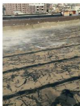
防水毯搭接處塗佈
