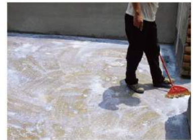
防水施工使用底漆
