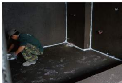
角隅-樹脂補強
