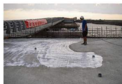
混凝土二次灌漿前滲透底漆施作
