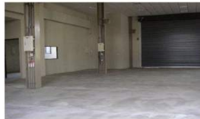
耐磨樹脂砂漿底漆施作
