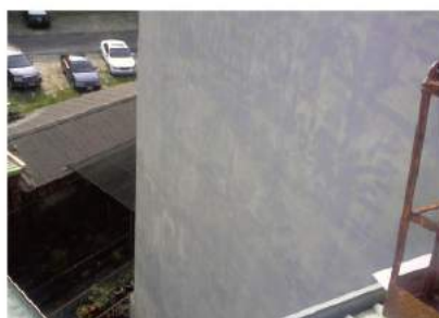
外牆牆面施作
