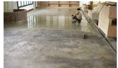
自平泥地坪底漆施作
