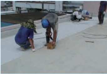
台灣日月光廠房防水施工
