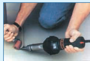
手提焊槍搭配20mm寬焊嘴和壓力輥用於手工焊接小面積的屋面PVC防水膜。
