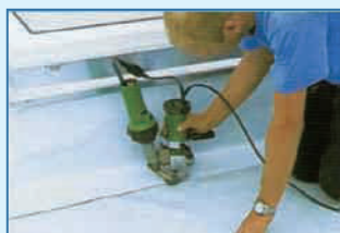
屋面PVC防水膜材的圓弧焊接面。
