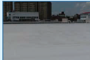
防水卷材完成面
