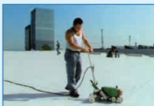
屋面PVC防水膜的搭接焊。
