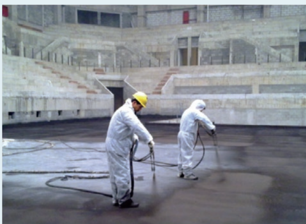
噴塗速凝橡膠防水塗料施工
