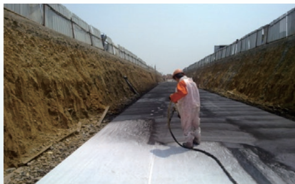
噴塗速凝橡膠防水塗料施工
