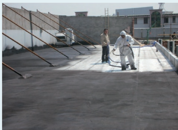
噴塗速凝橡膠防水塗料施工
