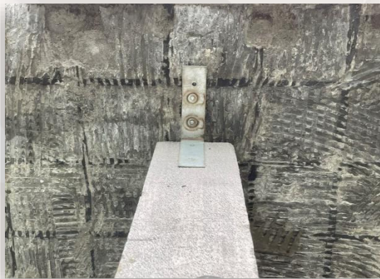
RC火藥槍釘打L型鐵件
