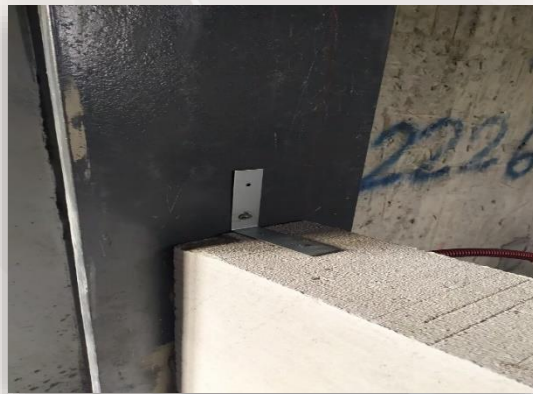
鋼構火藥槍釘打L型鐵件
